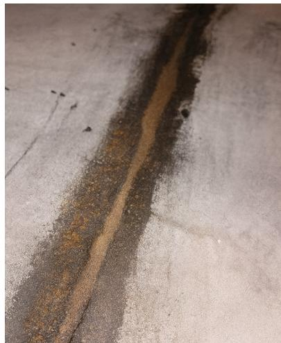
Remplissage du joint avec une égalisation de la surface et un ébavurage en bordure de dalle.
