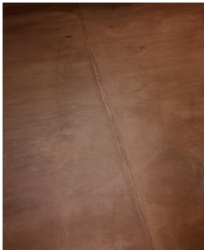
Joint de fractionnement qui se creuse avec une dégradation des bords de dalle.
