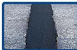
Tranchées et raccords
